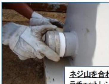
ネジ山を合わせて、手で締め込んだ後、ラチェットレンチ・スパナなどで締め込む。
