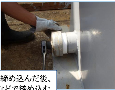
水抜きキャップを締める前に、ニップル部に時 計回りにシールテープを強めに巻き付ける。
